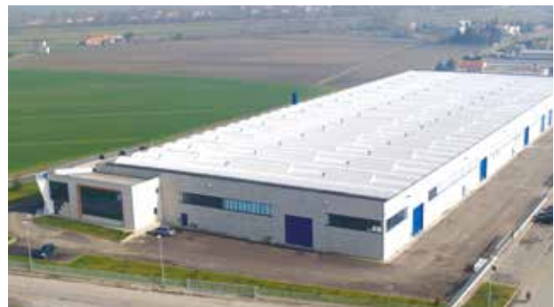
Sito produttivo di San Martino di Venezze (RO).
