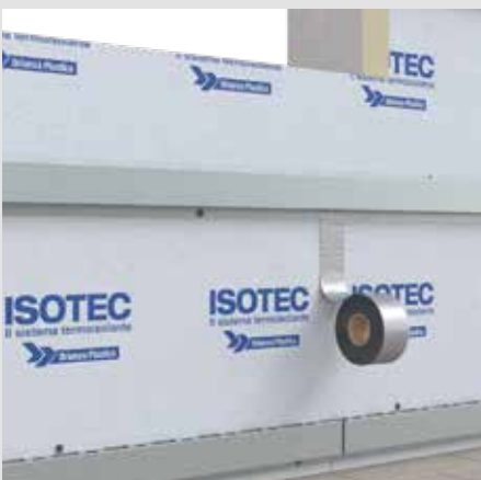
7 - Sigillatura dei giunti
