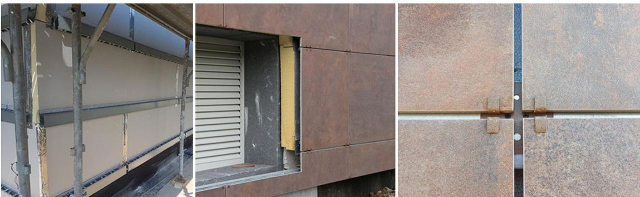
I 560 metri quadri di facciate ventilate realizzate con il sistema Isotec Parete, che completano la carta d'identità energetica dell'edificio, sono rifiniti esternamente da un **paramento in gres porcellanato** fornito da Emilceramica, avente nella **cromia ossidata** il suo punto di forza. Le lastre ceramiche da 120 x 60 cm sono sostenute e identificate dalle piastrelle verniciate con gancio a vista, vincolate al correntino metallico asolato di Isotec Parete mediante viti.
