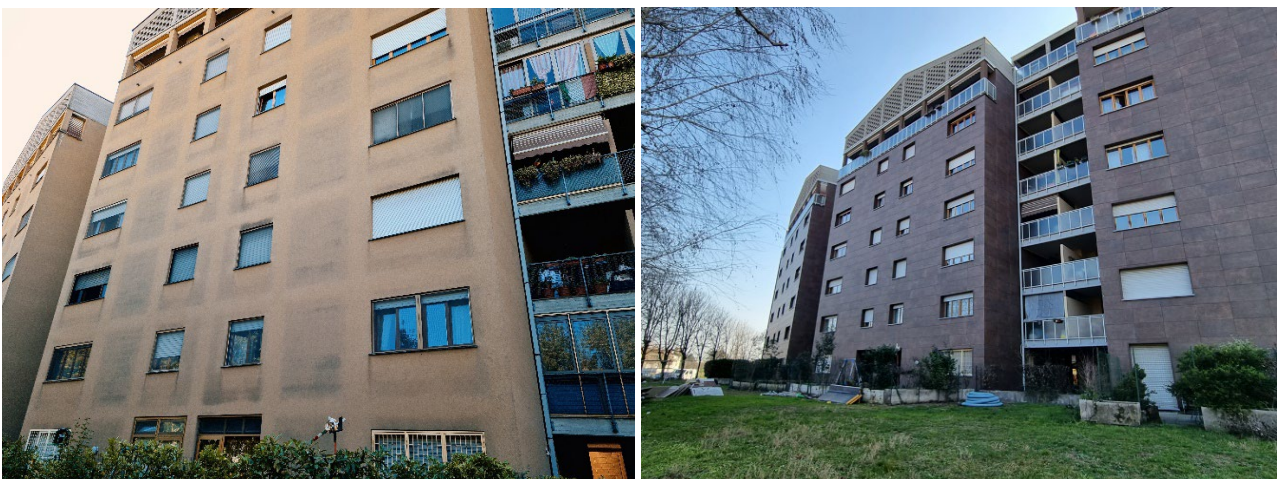
Gli edifici del complesso “Le Torrette” prima e dopo l'intervento.
