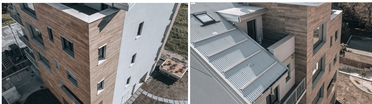
A sinistra, facciata con Isotec Parete in abbinamento a doghe in grès effetto-legno; a destra, tetto con Isotec Linea rivestito da lamiera metallica grecata.
