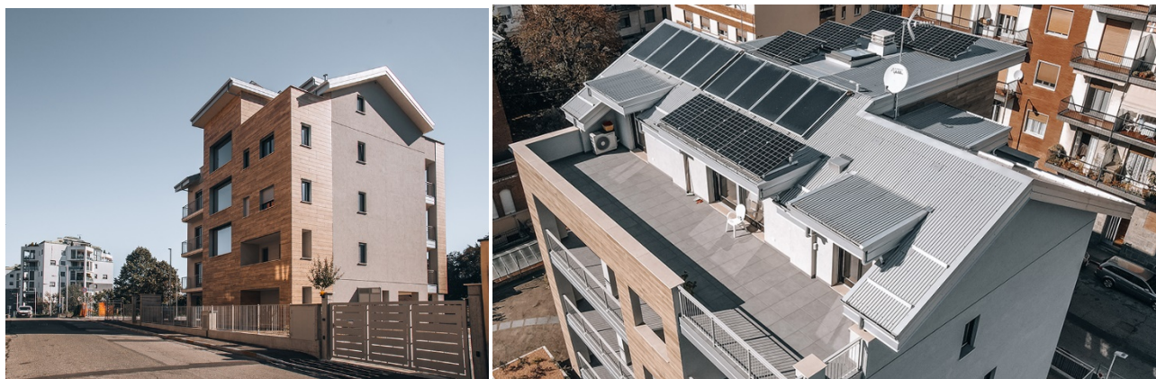
Edificio residenziale in Via May, Pinerolo (TO): in facciata Isotec Parete sp. 80mm, in copertura Isotec Linea sp. 120mm.
