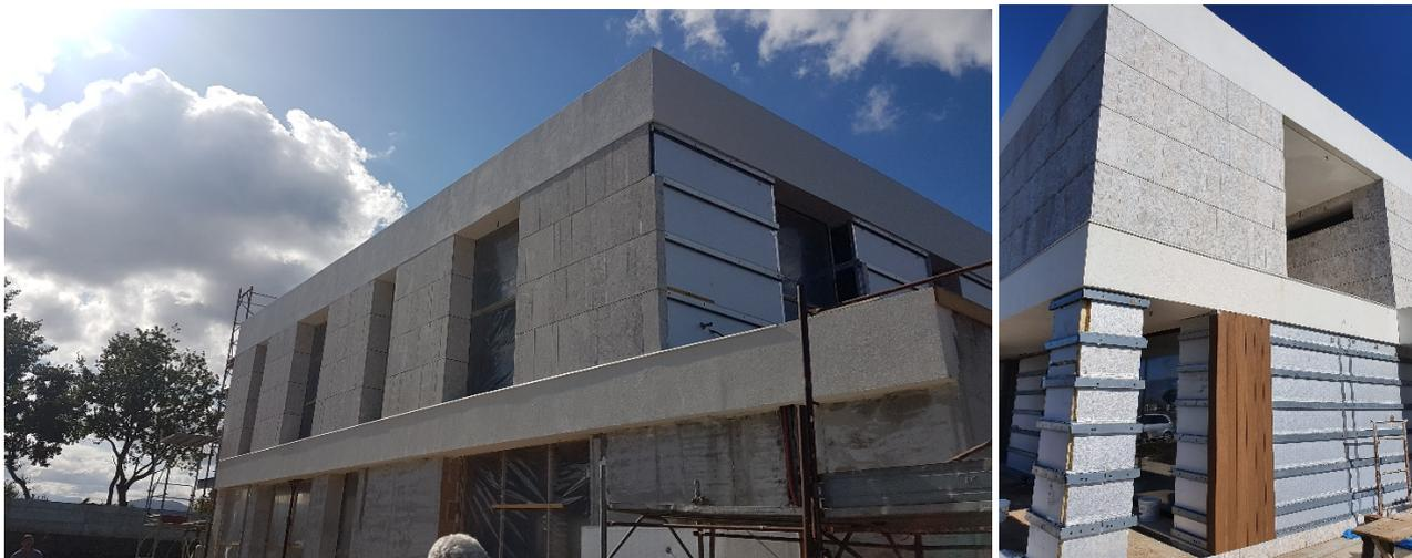
In entrambe le situazioni, Isotec Parete è stato posato in orizzontale, scelto in passo 65,2 cm per il piano superiore per accogliere le lastre in marmo e con passo 40 cm per le facciate inferiori, rivestite con i listoni in legno composto. Tutte e due le tipologie di finitura sono state fissate ai correntini metallici di Isotec Parete con apposite clip e morsetti a scomparsa, per **un effetto finale estremamente elegante e lineare**.
