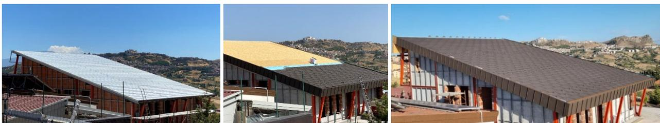
Il sistema **Isotec**, posato a giunti sfalsati, crea una protezione continua e ventilata dalla gronda al colmo, assicurando il passaggio dell'aria fra lo strato coibente e il rivestimento. L'accostamento dei pannelli a regola d'arte in fase di posa è facilitato dalla conformazione perimetrale dei pannelli, con finitura battentata sui lati
