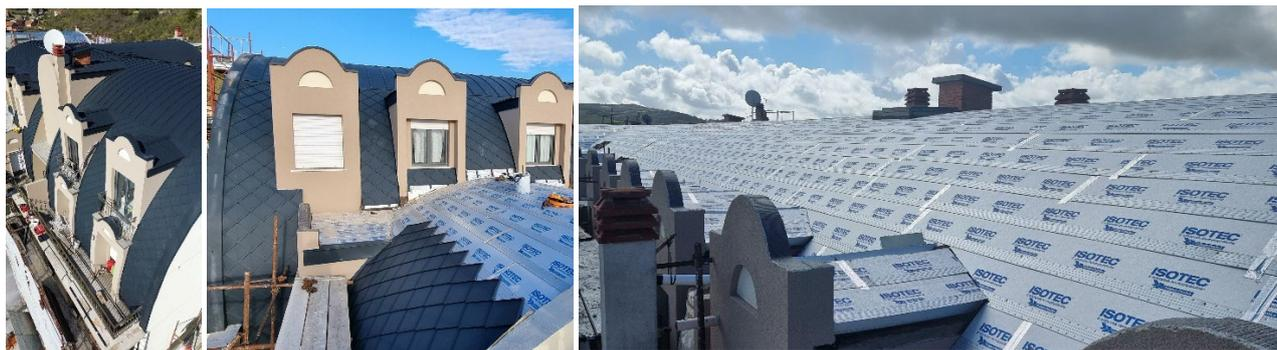
La praticità del sistema e la velocità di posa si possono apprezzare nella numerica dell'opera: sono stati necessari solo 45 giorni e il lavoro di 5 persone per posare il pacchetto isolante completo del rivestimento in alluminio e delle opere di lattoneria su una superficie di copertura complessiva di 1.600 mq, su cui si affacciano circa 50 abbaini.
