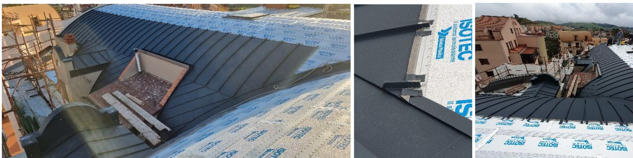
Isotec Linea è un pannello pre-accoppiato con anima in poliuretano espanso rigido rivestito con una lamina di alluminio gofrato che lo rende impermeabile, a cui è assemblato direttamente in fabbrica un correntino
