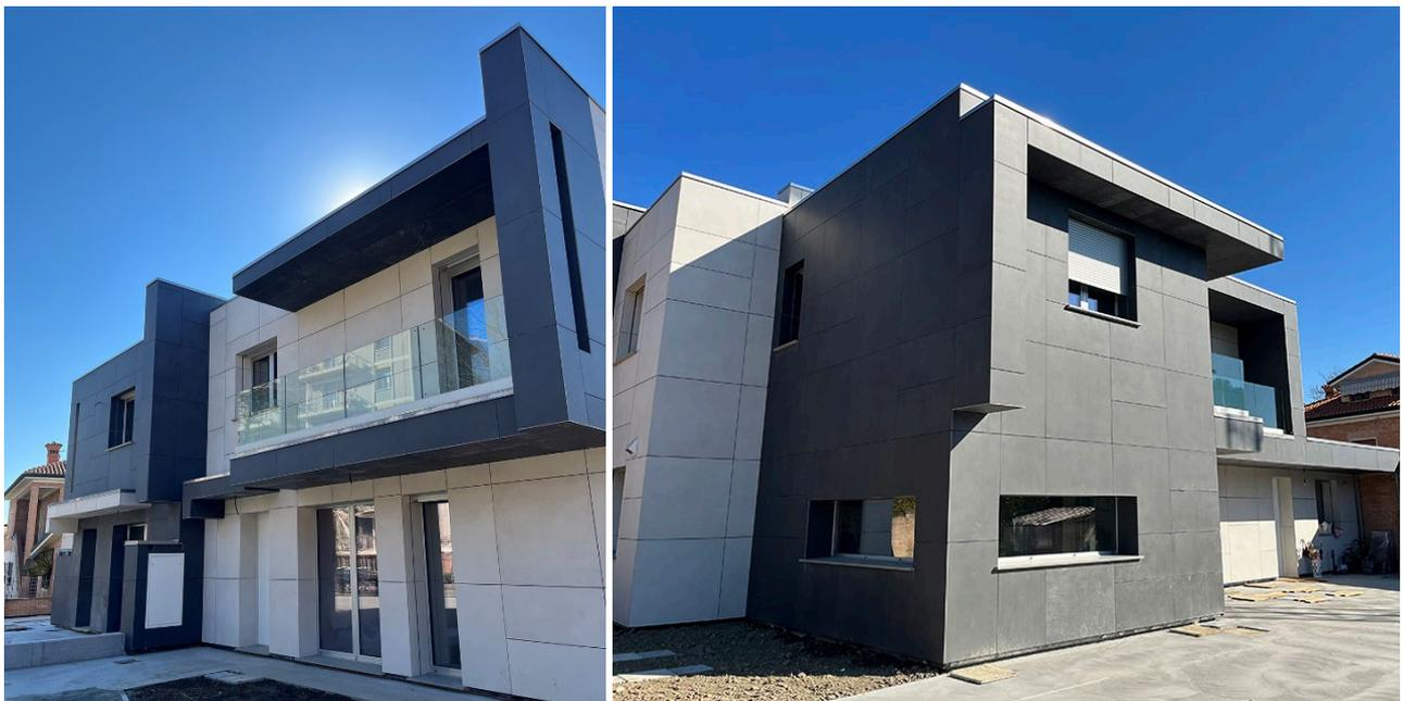
Isotec Parete è un sistema isolante preaccoppiato che si applica completamente a secco, mediante tassellatura, su qualsiasi supporto ed è costituito da un'anima isolante in **poliuretano espanso rigido ad alte**
