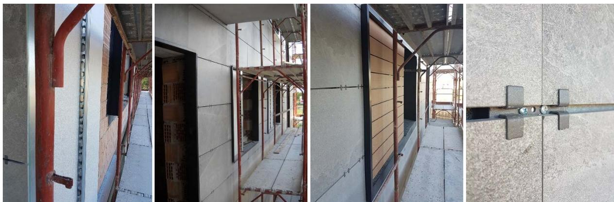
Il sistema Isotec Parete - scelto nel passo 60 cm - è stato posato in verticale, con le lastre in grès posate in senso orizzontale e fissate al correntino metallico di Isotec Parete con “manine” a vista, che abbracciano interamente lo spessore della ceramica. Le clip sono poi state verniciate con una finitura screziata in tinta con il rivestimento, che consente di creare un effetto di invisibilità delle clip, una volta in opera.
