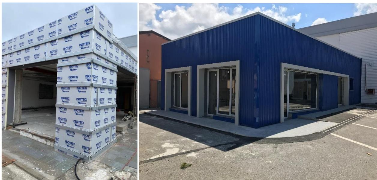
**La posa completamente a secco** di tutti gli elementi della facciata ha consentito di mantenere un'**estrema pulizia** in cantiere mentre la leggerezza e manovrabilità dei pannelli sono stati preziosi alleati nelle fasi di posa. La battentatura, che caratterizza i bordi del pannello, ha semplificato le operazioni di installazione e consente di realizzare in modo pratico e veloce un isolamento continuo, privo di ponti termici.
