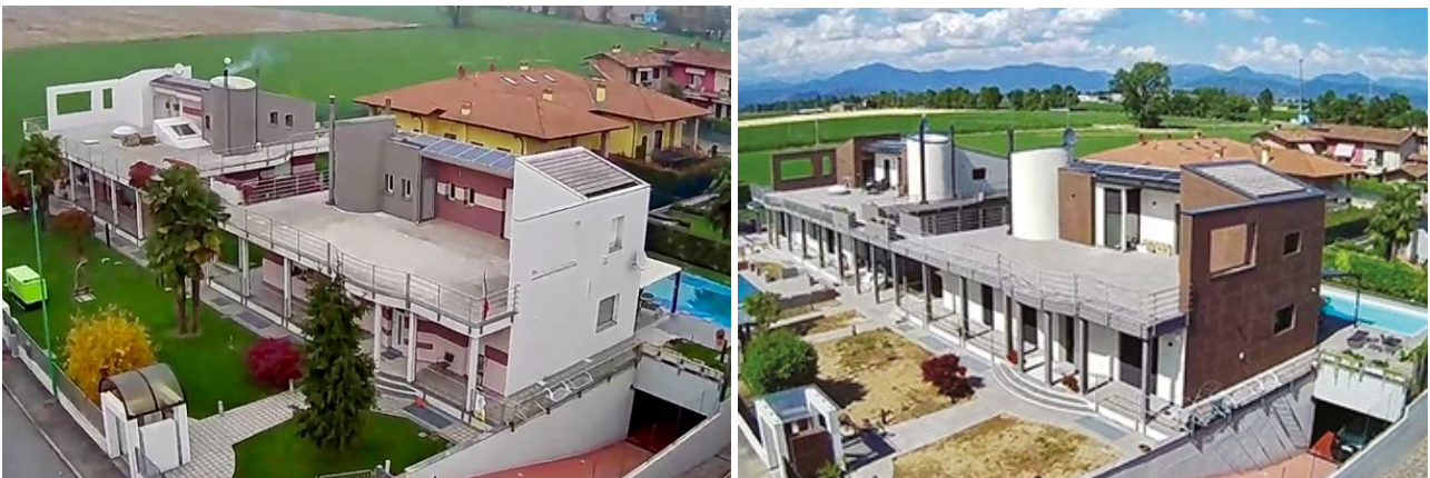
Le ville di Ghisalba (BG) prima e dopo l'intervento di ristrutturazione
