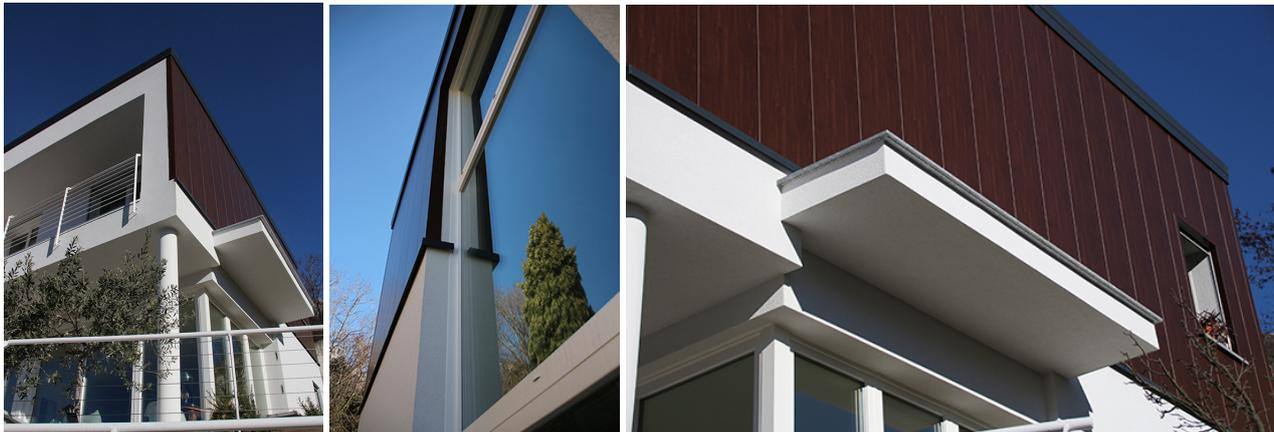
Per questo progetto è stato scelto, per il rivestimento del piano terra, **l'abbinamento di Isotec Parete con i pannelli in fibrocemento portaintonaco Elycem**, una soluzione fornita a pacchetto da Brianza Plastica. Per il piano superiore, invece, Isotec Parete è stato rivestito con originali **doghe in alluminio** lunghe 3 metri montate in verticale, con finitura effetto rovere.
