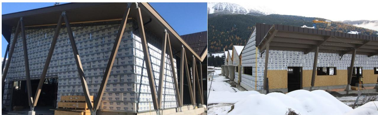
Per la realizzazione dell'**originale rivestimento metallico in nastro aggaffato**, scelto in tre colorazioni ispirate alla natura (marrone, testa di moro e nero), l'azienda **Nieder** ha proceduto fissando ai correntini metallici di Isotec Parete i pannelli in OSB, in modo da creare un sottofondo continuo adatto al fissaggio dell'alluminio. La lavorazione dei nastri è stata eseguita con cura artigianale nei laboratori della Nieder e poi portati in loco e fissati con apposite graffette.
