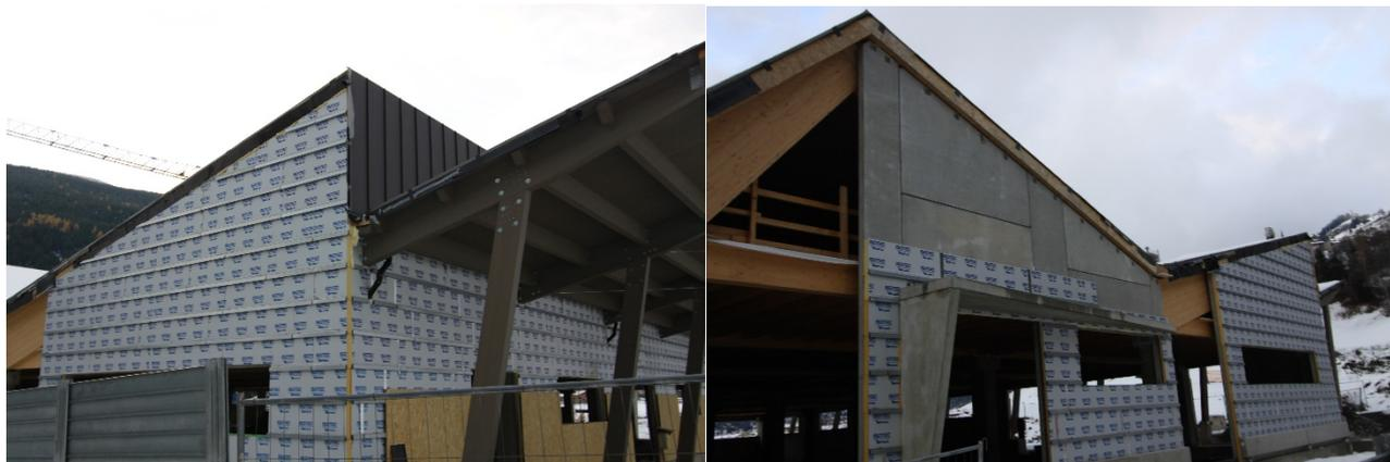
L'**impermeabilità del pannello** - insensibile all'umidità e protetto da un rivestimento di alluminio goffrato - e la **posa a secco** del sistema hanno avuto un ruolo fondamentale nell'**ottimizzazione delle tempistiche del cantiere**, poiché hanno consentito di lavorare senza alcun problema o limitazione nei mesi invernali anche con la pioggia, la neve e temperature rigide.
