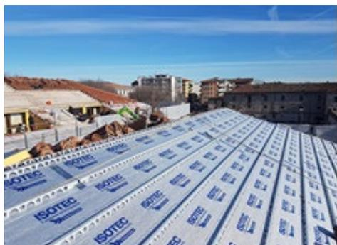
realizzato il **colmo ventilato**, massimizzando gli effetti benefici del sistema ventilato. Sono state infine montate anche le nuove linee salvavita, fissate direttamente alla struttura portante, passanti attraverso l'isolante.
