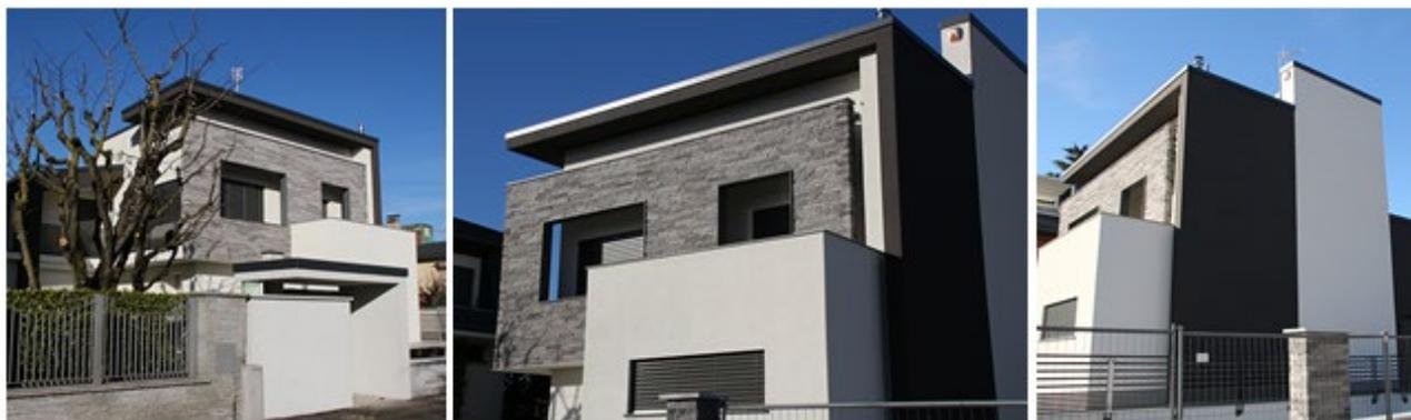
La struttura è realizzata con un sistema a travi e pilastri in cemento armato e blocchi di tamponamento in laterizio, la cui massa offre buoni risultati acustici. Dal punto di vista termico, la coibentazione è stata realizzata con un **sistema di facciata ventilata**, che dota l'involucro di ottime prestazioni isolanti sia in regime invernale che estivo, rispondenti ai parametri energetici previsti dalla normativa della Regione Lombardia.
